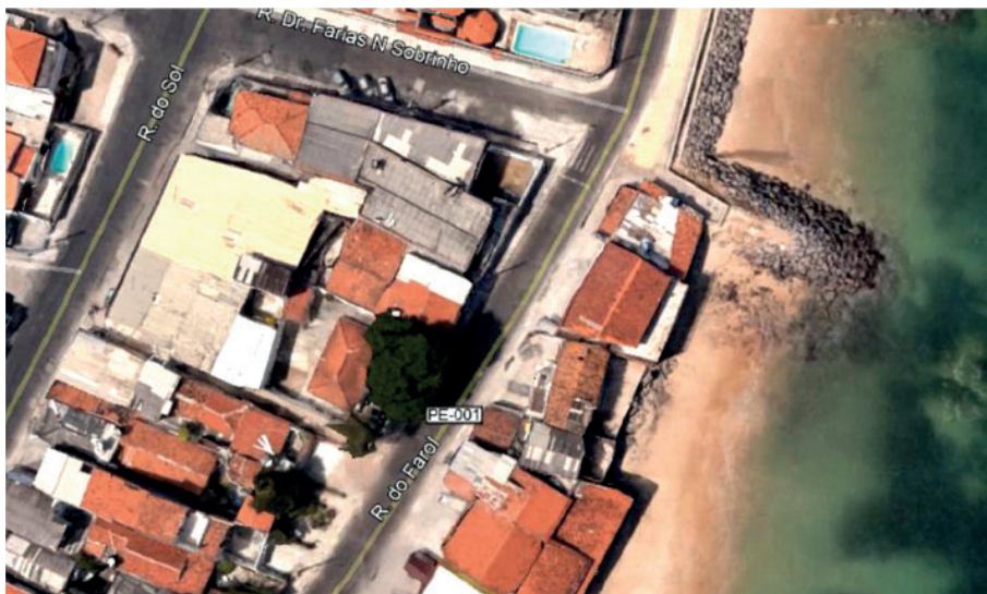
Figura 9: Remanescente da antiga casa do faroleiro, propriedade federal desabitada e em arruinamento, indicada pela seta branca
