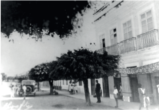
Figura 2: Os sinais do aburguesamento no centro da cidade na década de 1950
