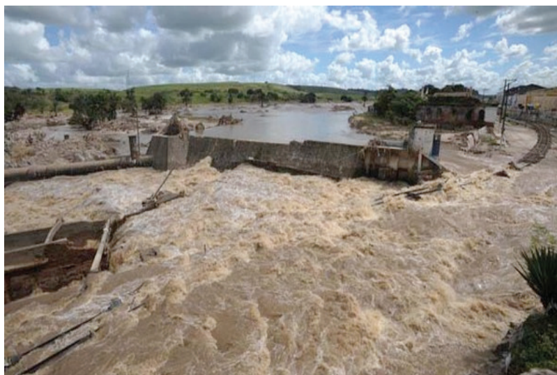
Figura 1: Dique roto en las inundaciones de 2010 en la ciudad de Río Largo
