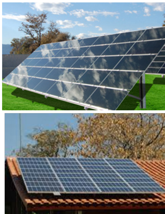
Figura 6 Instalação dos painéis fotovoltaicos no solo, em telhados e fachadas de prédios
