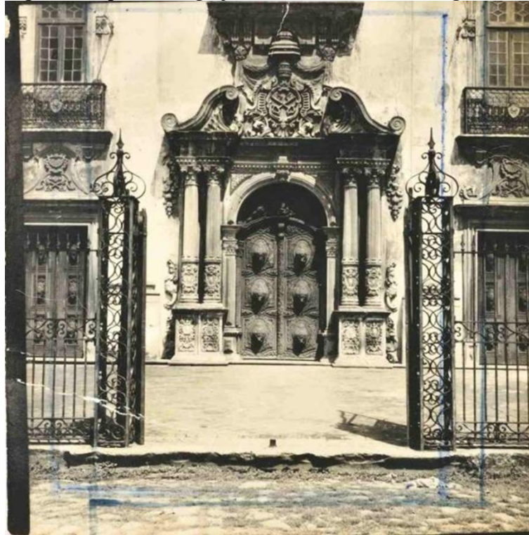
Figura 5: Fotografia da porta da Igreja de São Pedro dos Clérigos na década de 1930
