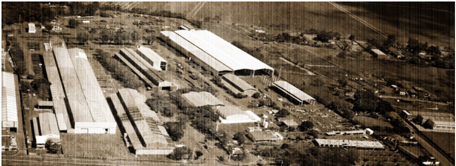
Figura 5: Instalações da Zanini S.A, fundada por Maurílio Biagi.
